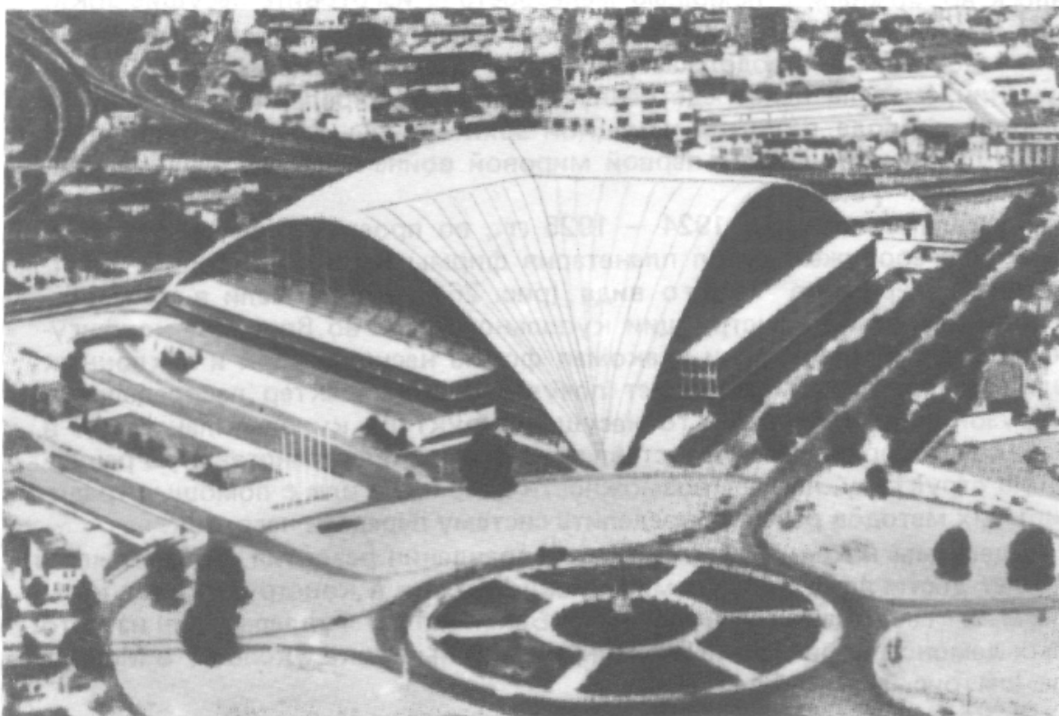
Рис. 52. Общий вид Главного павильона Национального центра промышленности и техники в Париже. Расстояние между опорами — 205,5 м, высота оболочки в ее верхней точке — 46,3 м. Покрытие представляет собой треугольный купол, выполненный по принципу крестового свода
